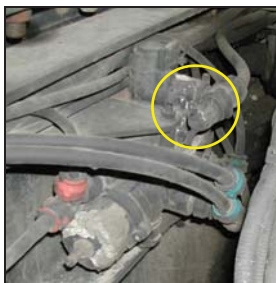
Sl. 8.36 Kontrolni priključak na ARSK ventilu
